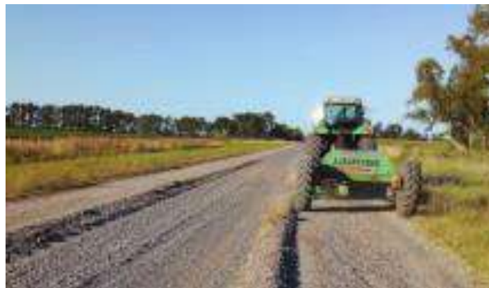
Figura 2: Arreglo mejorado de caminos en Carlos Beguerie
