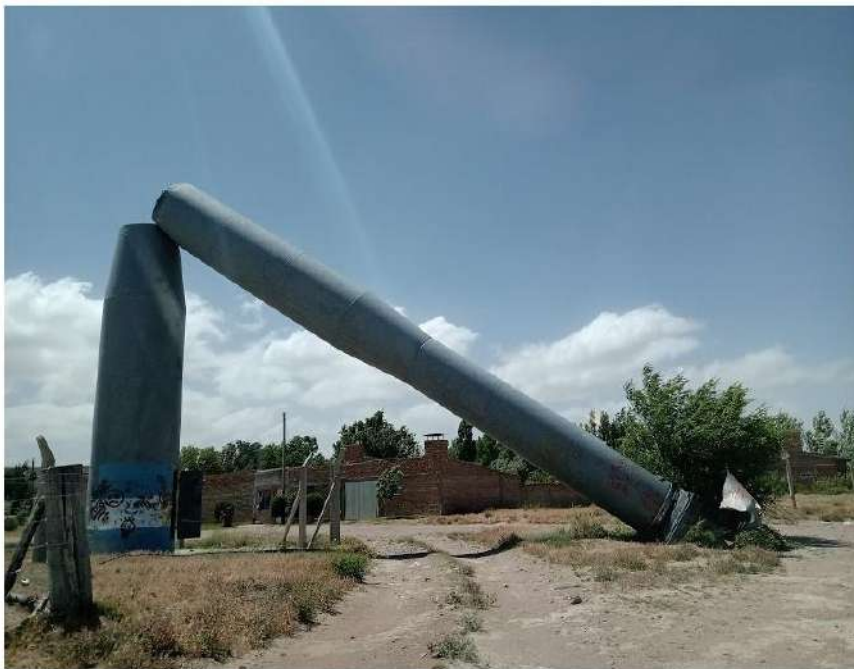
Imagen 4: Condiciones actuales del Generador Eólico
